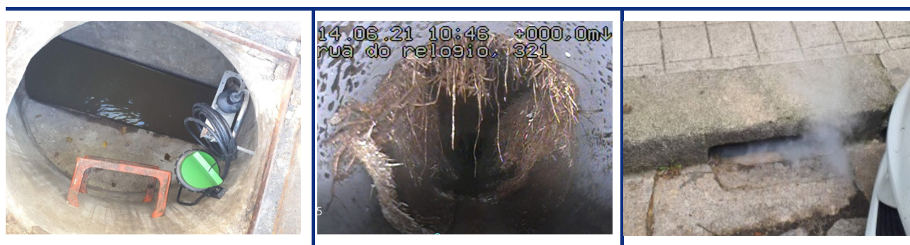
Figura 10 – Intervenções previstas para deteção de afluências indevidas
