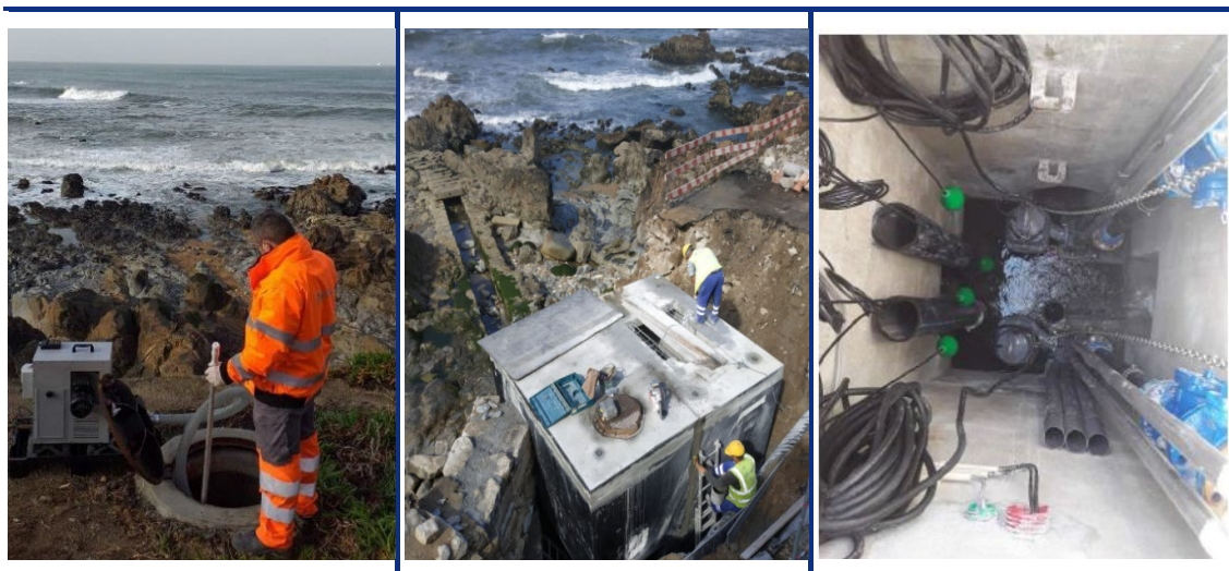
Figura 11 – Intervenções realizadas na frente marítima
