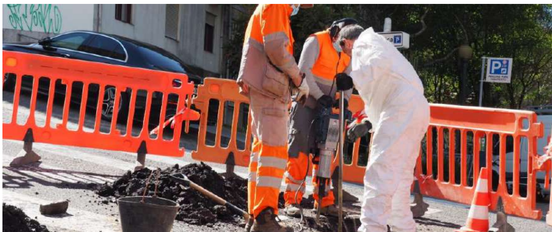
Figura 2 | Arranque da empreitada contínua para a substituição de troços de condutas problemáticos
